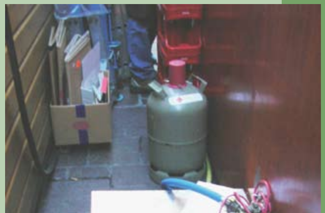
Unzulässige Lagerung von Flüssiggas neben brennbaren Gegenständen.
